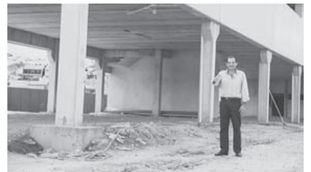
Visita de Chedid às obras do ambulatório
