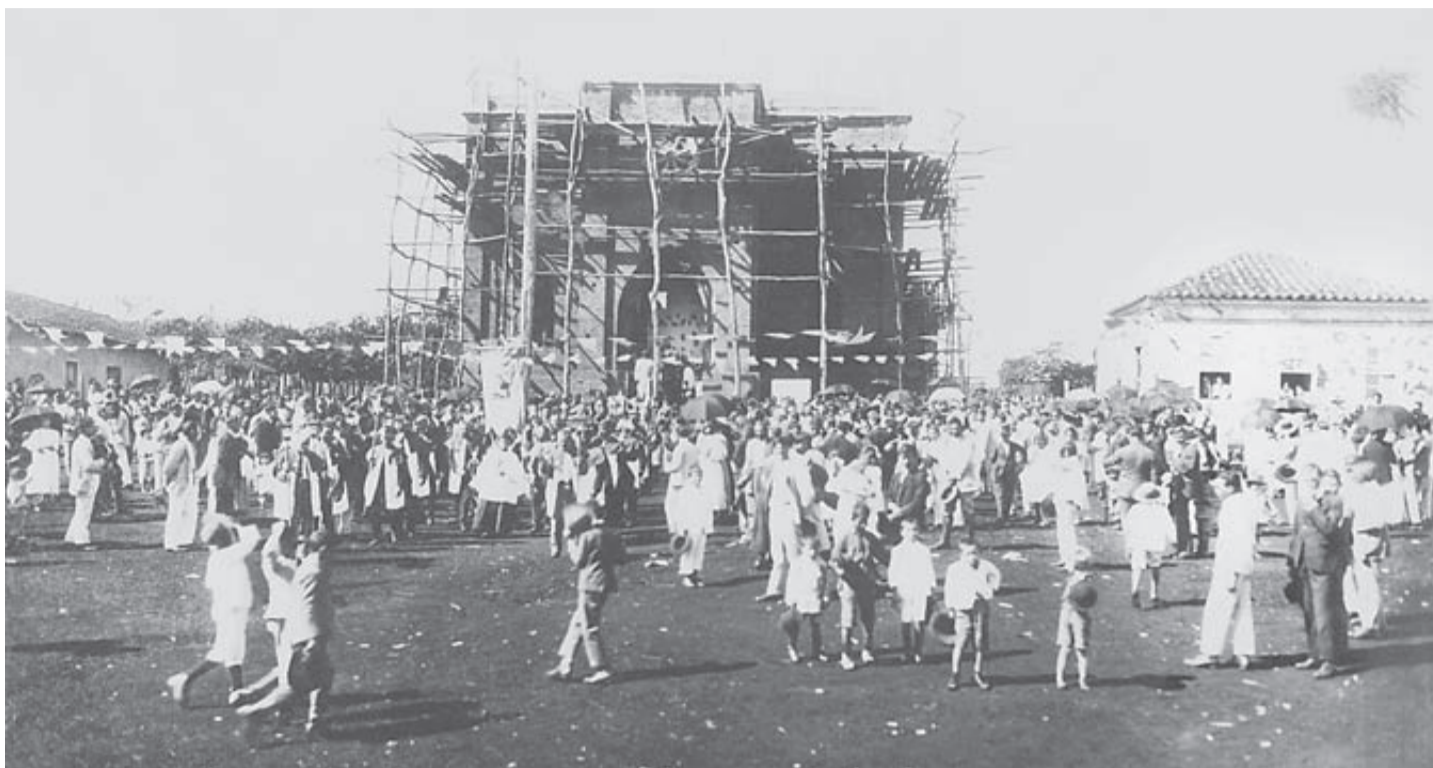
Moradores do Distrito de Bocaiúva, hoje cidade de Macatuba, em frente à igreja matriz em construção, 1922
